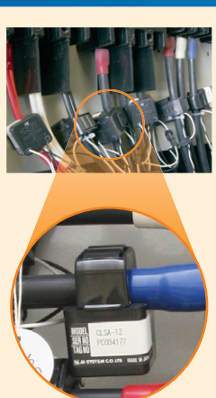
電流信号の検出はクランプするだけでOK！動力線の解放は不要です。
