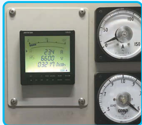
高圧配電盤に設置したくにまる子機と電力マルチメータ
