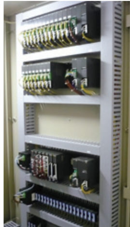
図1 盤内に設置されたD3シリーズ
