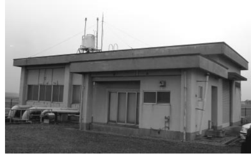
図1 揚水機場外観
