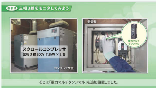
三相3線式電源の装置への取付け
