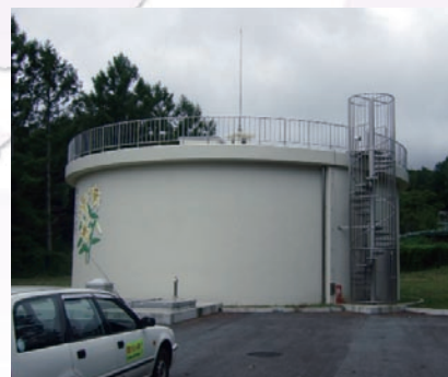
図1 配水池の外観
