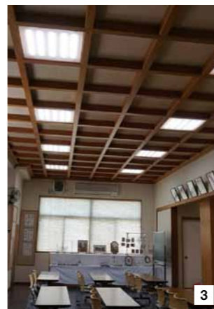
①本堂の照明は全てエム・システム技研の万能直管LEDライトに替えられた ②LEDは紫外線が出ないので本尊も掛け軸も照明による劣化の心配が要らない ③地域のギャラリーとしても親しまれている本堂の天井の高さは約3メートル。蛍光灯と違いLEDは長寿命なので交換の手間がほぼなくなった ④谷川弘顕住職
